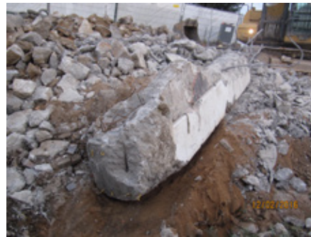
Stützen, Bodenplatte und Fundament, da war nicht viel mit Eisen und Bewehrung.
