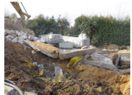
Stützen, Bodenplatte und Fundament, da war nicht viel mit Eisen und Bewehrung.
