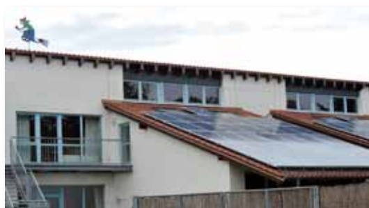
Verschieferung schützt nun die Fenster vor Verwitterung
