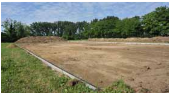
Hier entsteht der neue Bolzplatz
